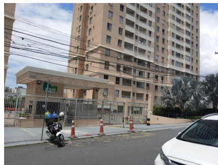
Representação Fachada Principal Descrição Data Foto 11/01/2022
