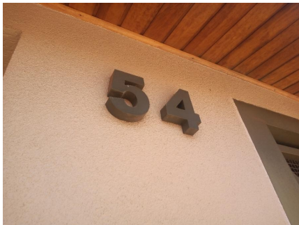
Representação Vista da Rua Descrição VIZINHO DIR Data Foto 29/12/2021
