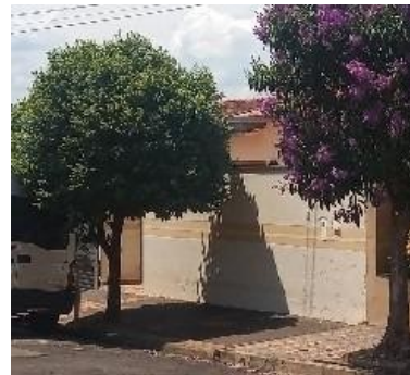
Representação Fachada Principal Descrição Data Foto 30/12/2021
