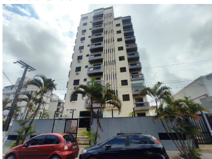
Representação Fachada Principal Descrição FACHADA CONDOMÍNIO Data Foto 16/12/2021
