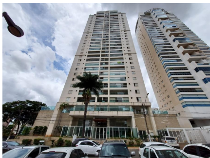
Representação Fachada Principal Descrição Data Foto 11/11/2021
