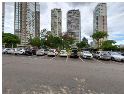
Representação Fachada Principal Descrição Data Foto 11/11/2021
