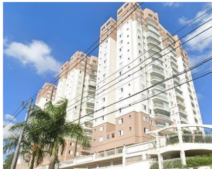
Representação Fachada Principal Descrição Data Foto 18/11/2021
