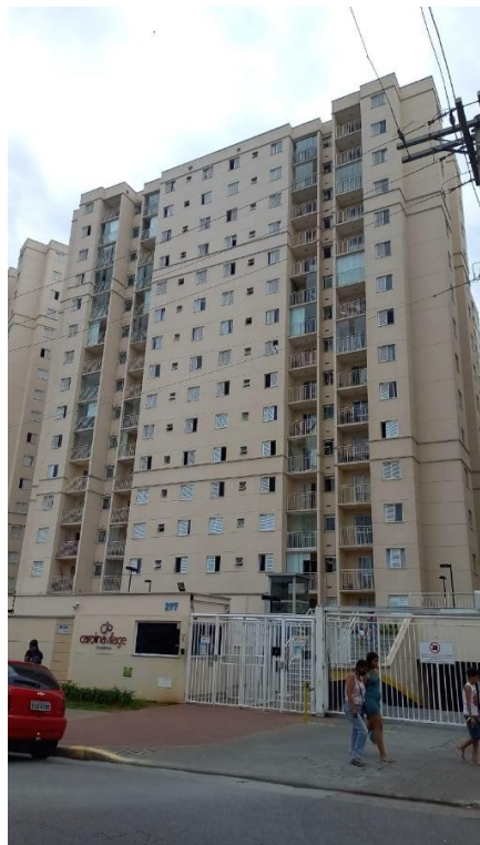
Representação Fachada Principal Descrição Data Foto 16/10/2021
