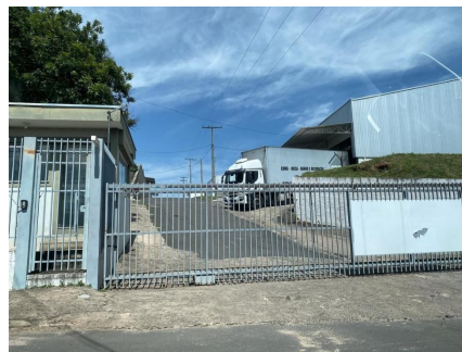
Representação Fachada Principal Descrição Data Foto
