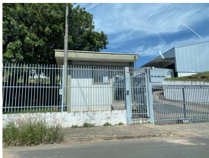
Representação Fachada Principal Descrição Data Foto
