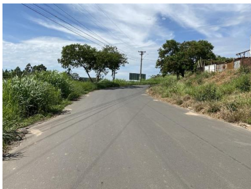
Rua de Acesso
