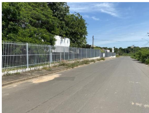
Rua de Acesso
