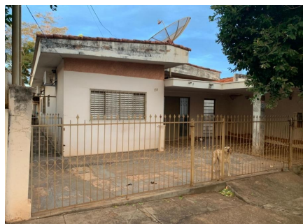
Representação Fachada Principal Descrição Data Foto 24/02/2021
