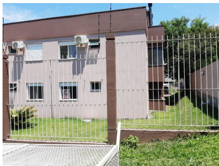
Representação Fachada Principal Descrição Data Foto 08/02/2021
