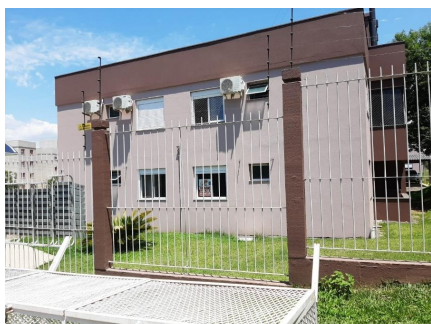
Representação Fachada Principal Descrição Data Foto 08/02/2021
