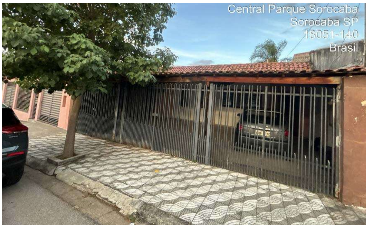
Foto 01: Frente do imóvel
