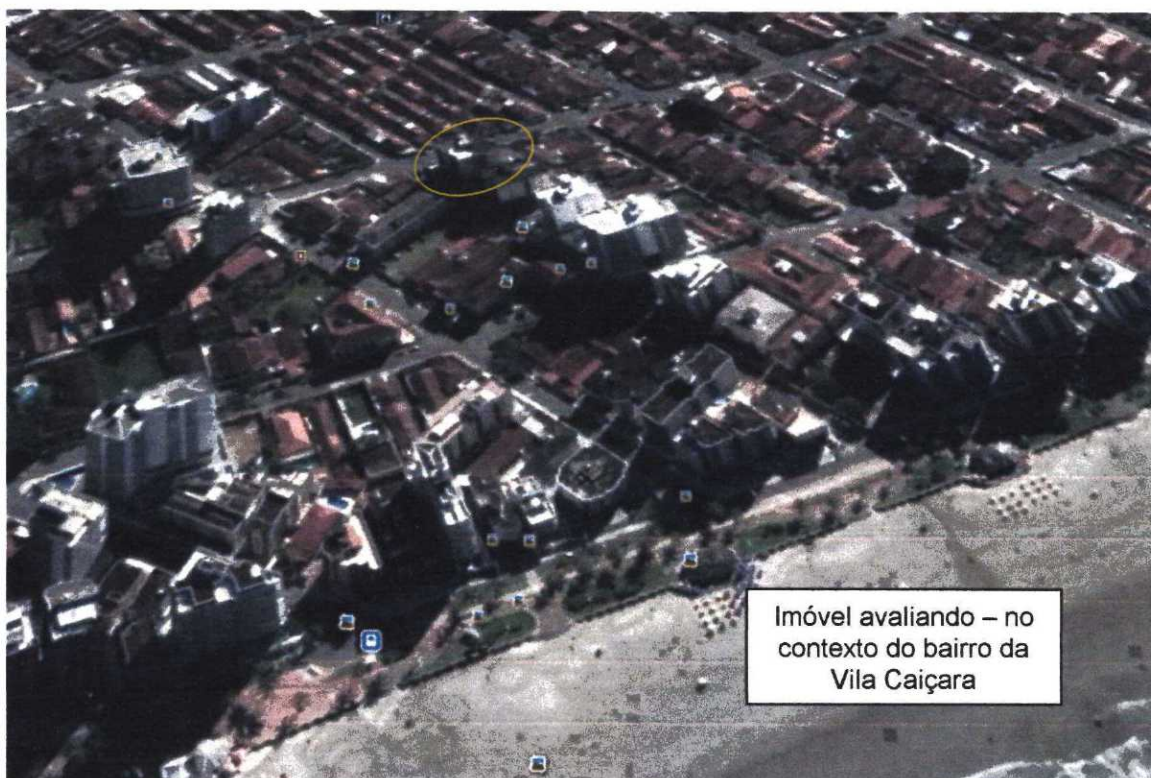
Foto 1 – Vista geral do entorno do imóvel em questão.
