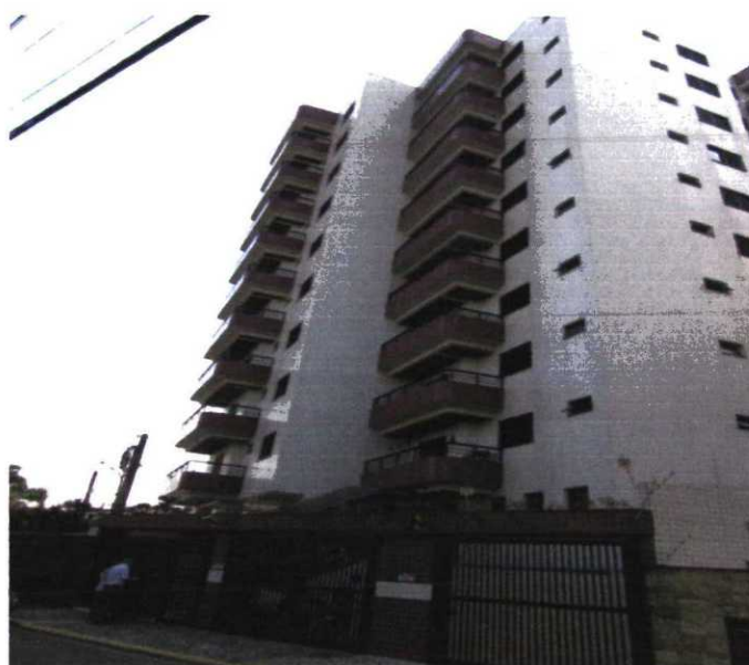
Foto 12 – Vista da fachada do Edifício Residencial Itaparica.
