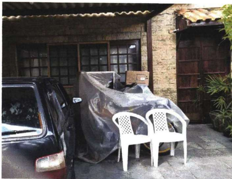
Foto 09 – Vista do recuo frontal do imóvel sob o nº 503.
