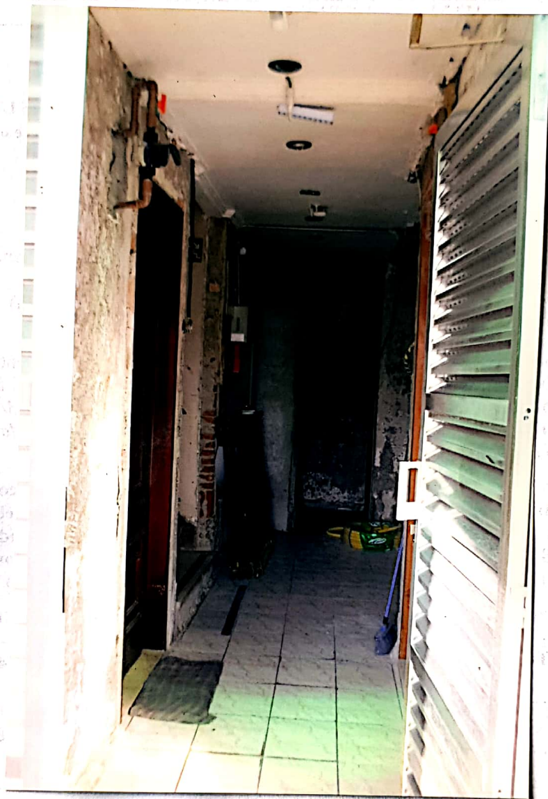
Foto nº 6 – corredor que dá acesso aos apartamentos.
