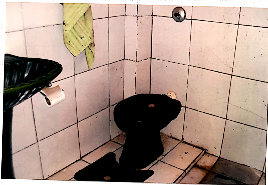
foto nº12 - banheiro social com piso e paredes de cerâmica e louça sanitária de padrão comercial
