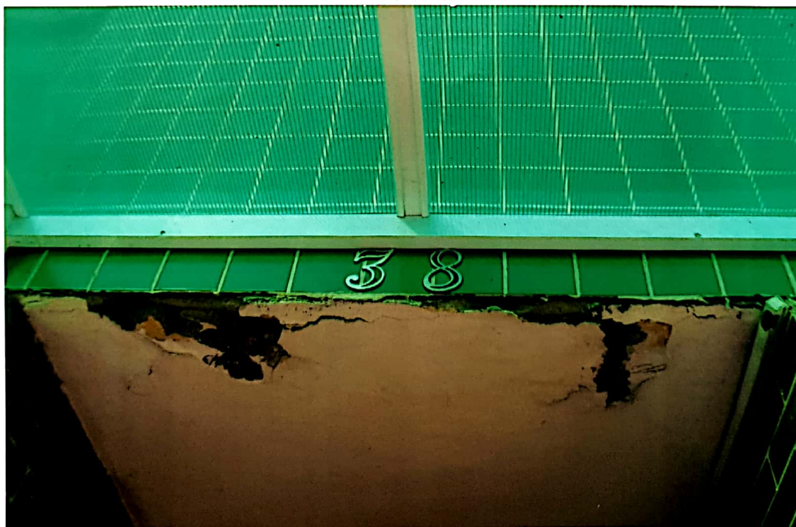
Foto nº 5- detalhe da fachada com revestimento cerâmico
