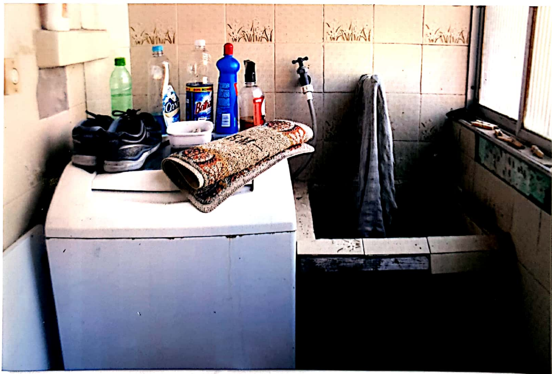
Foto nº 14 – área de serviço com piso de cerâmica, paredes com azulejos decorados e tanque revestido de azulejos.
