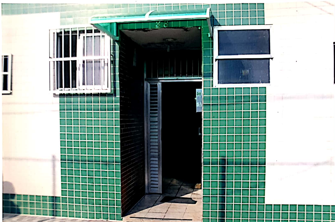
Foto nº 4 – Hall de entrada do Condomínio Verde Mar II – Bloco 2C do apartamento nº 34-avaliando.
