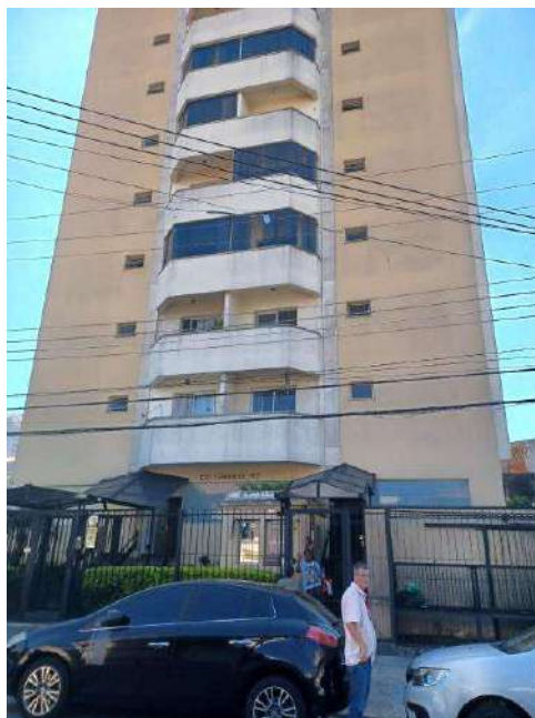
FOTO 1 – FACHADA DO CONDOMÍNIO
