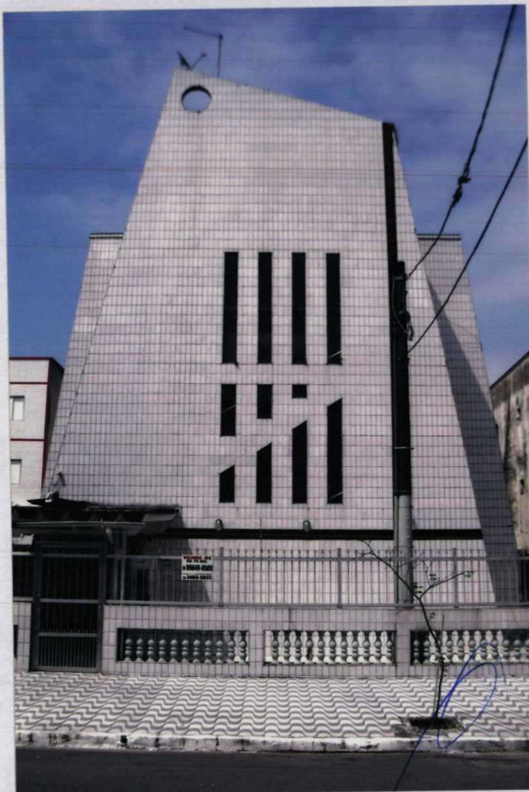
Foto nº 01 – fachada do Edifício Onix, frente para Rua Kikusaburo Tanaka, do apartamento nº 312-avaliando,
