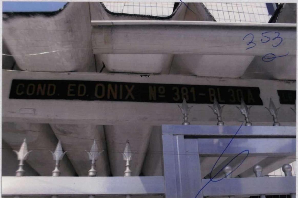
foto nº 3 - detalhe identificação do EDIFÍCIO ÔNIX
