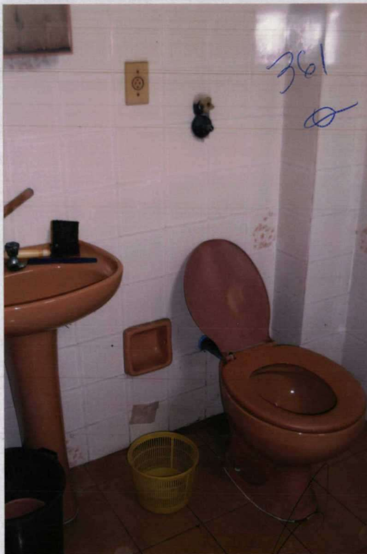
Foto nº 10 – banheiro com piso e paredes de cerâmica, louça sanitária de padrão comercial em bom estado de conservação.
