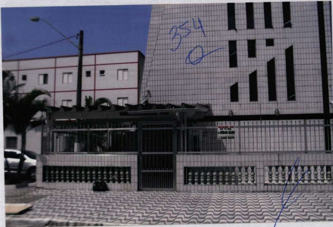
Foto nº 02 - detalhe da portaria do Condomínio
