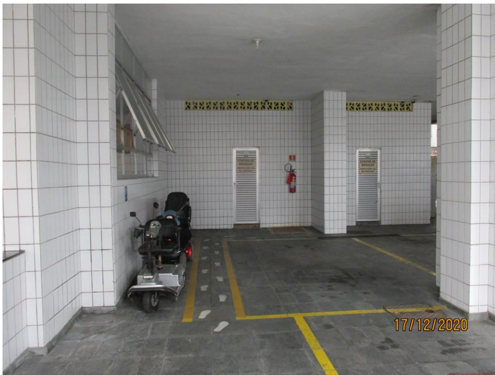
Foto 4 - Vagas de garagem no andar térreo
