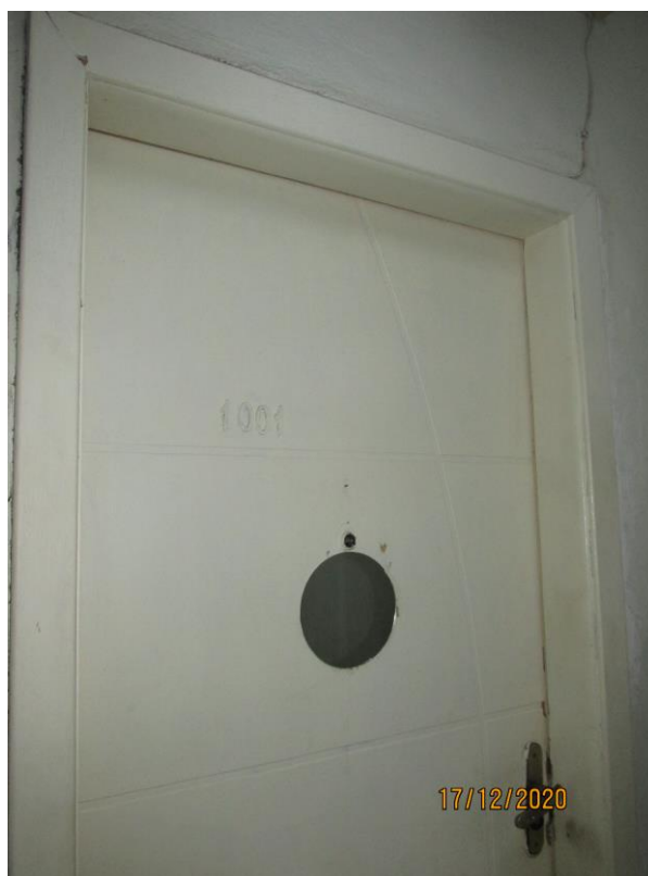
Foto 20 - Porta de entrada do apartamento avaliando
