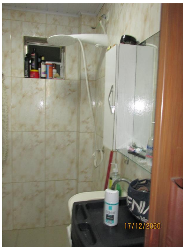
Foto 24 - Banheiro com revestimento em azulejos até o teto
