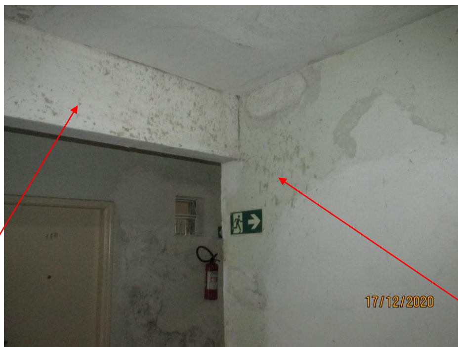
Fotos 17 e 18 - Manchas escuras devido as infiltrações nas paredes e tetos dos corredores de circulação e escadarias – áreas comuns
