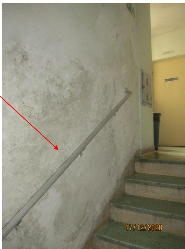
Fotos 17 e 18 - Manchas escuras devido as infiltrações nas paredes e tetos dos corredores de circulação e escadarias – áreas comuns
