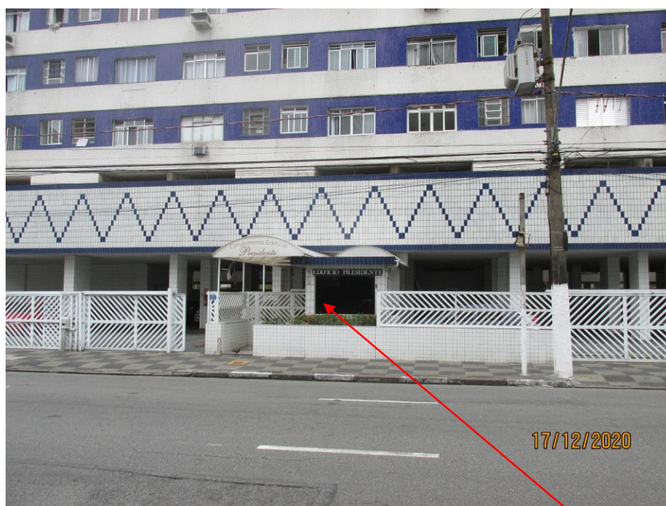
Foto 2 - Detalhe da entrada do edifício - portaria
